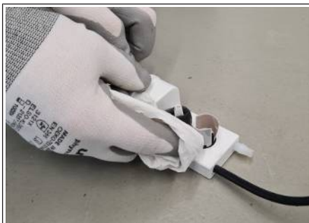
Abb. 44: Kondensatpumpe reinigen
