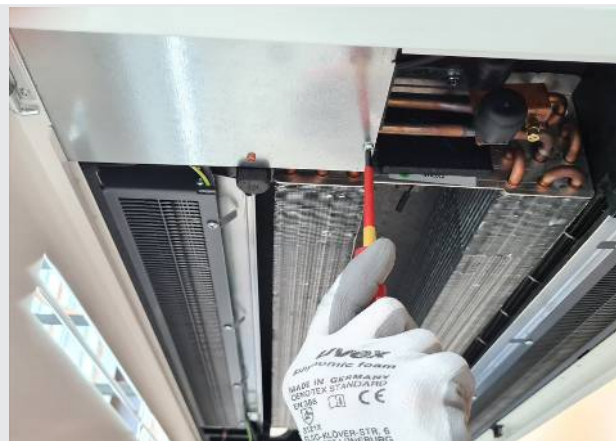
Elektroanschlusskasten mit Kreuzschraubendreher öffnen und den Deckel der Elektroanschlussbox abnehmen.
