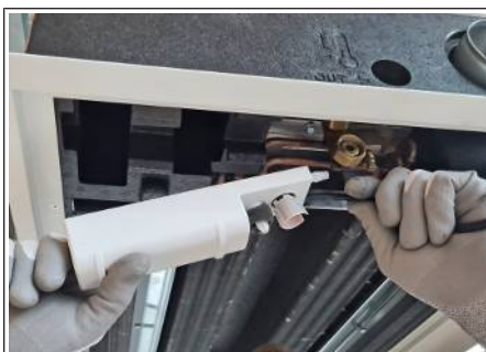
Abb. 43: Kondensatpumpe demontieren
