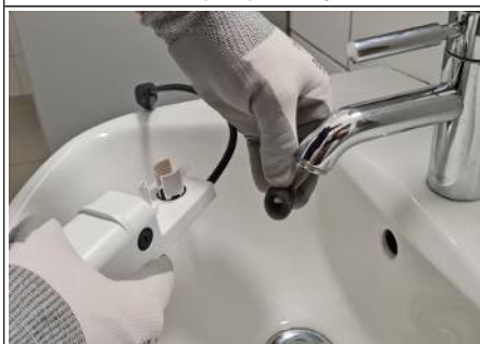
Abb. 45: Schmutzfilter reinigen
