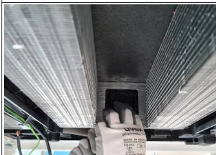
Abb. 24: Primärluftabdeckung entfernen
