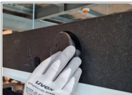
Abb. 22: Primärluftstutzen abnehmen
