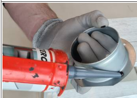
Abb. 23: Primärluftanschlussstutzen abdichten
