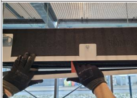
Abb. 7: Sicherungsblech eindrücken
