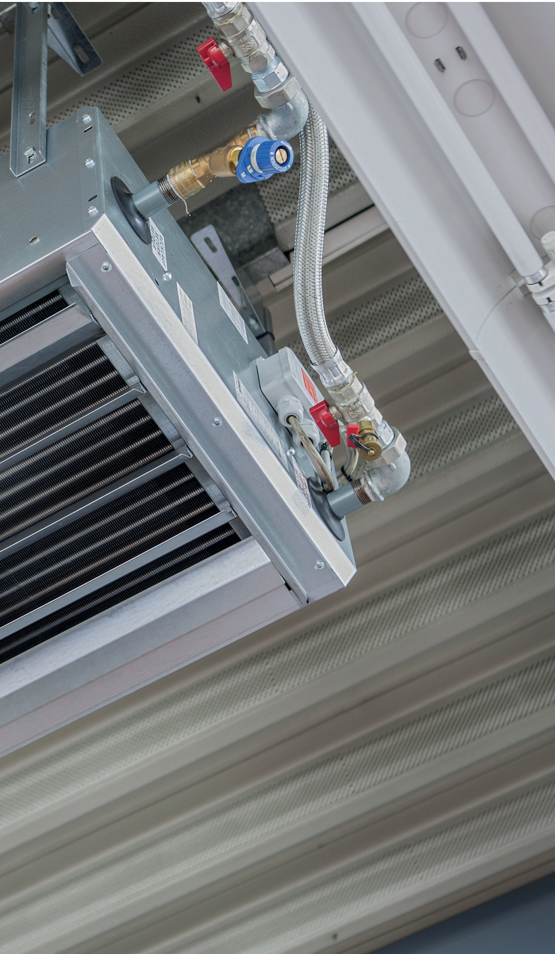
An den Decken montierte TIP Luft- erhitzer beheizen die Ausstellungshalle des Autohauses Seyfarth in Gotha.
